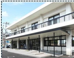
広島産業会館「本館」 入口
